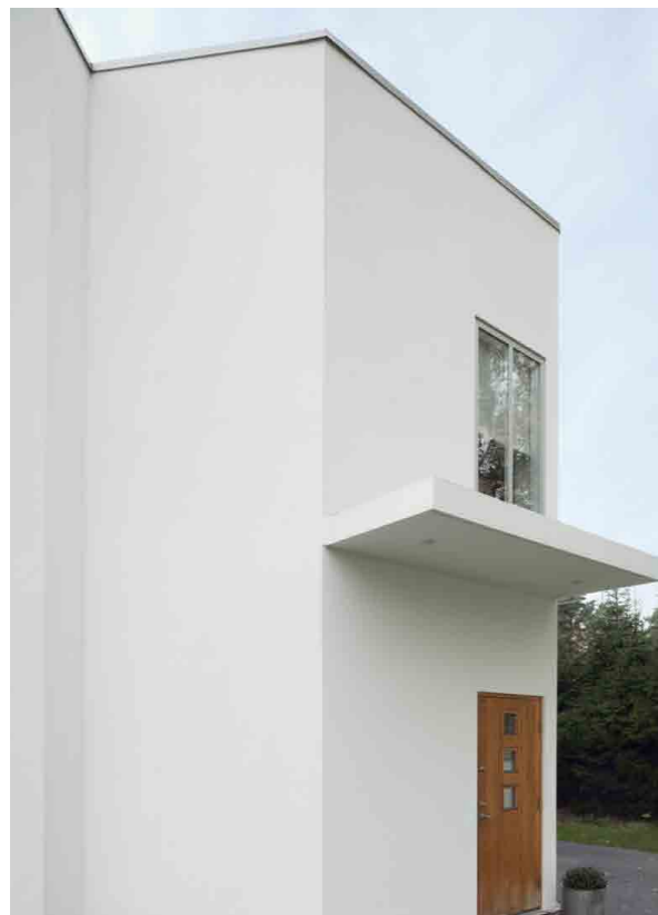
Modernt eller klassiskt – husets typ, och arkitektur avgör färgsättningen.
